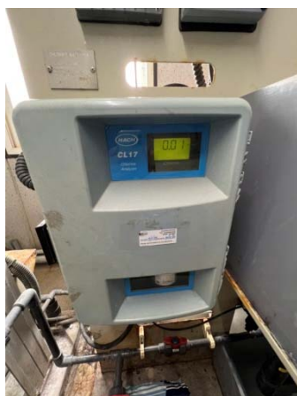
รูปที่ 43 เครื่องตรวจวัดความเข้มข้นของคลอรีนแบบต่อเนื่อง
