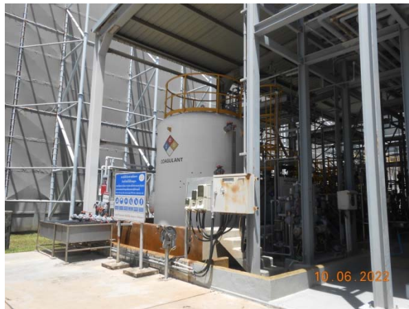
รูปที่ 40 ระบบบำบัดน้ำเสียแบบเคมี
