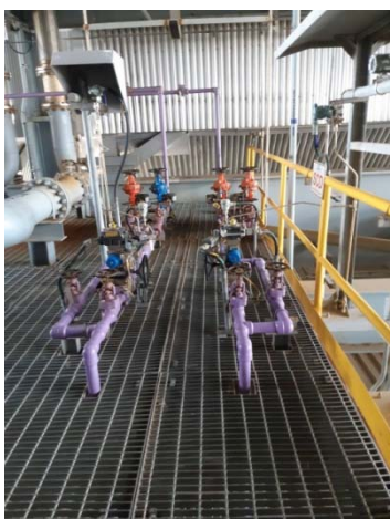
รูปที่ 16 อุปกรณ์ควบคุมออกไซด์ของไนโตรเจน (SCR)
