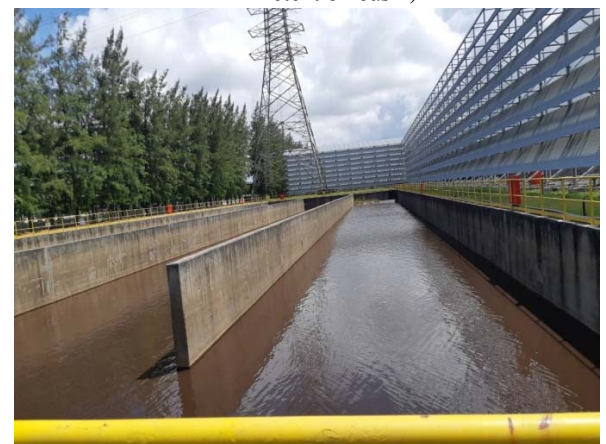
รูปที่ 39 บ่อ run-off pond
