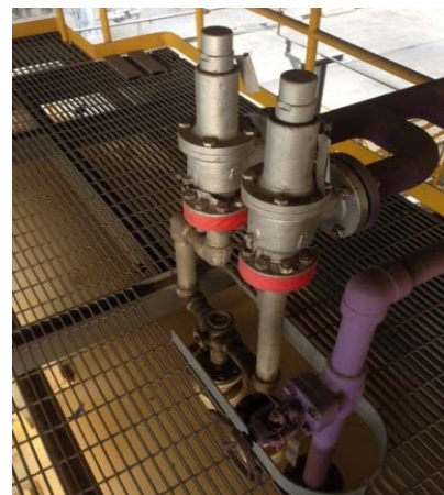
รูปที่ 104 วาล์วลดความดันเพื่อป้องกันความเสียหายของถังแอมโมเนีย
