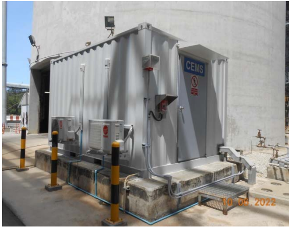
รูปที่ 20 CEMs Analyzer Shelter ของโรงไฟฟ้า
