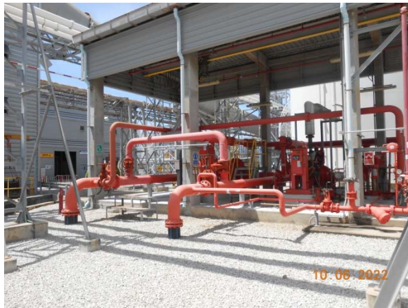
รูปที่ 101 ระบบสูบน้ำดับเพลิง
