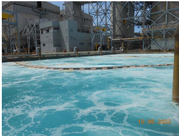
รูปที่ 45 ระบบบ่อเติมอากาศ (aeration basin)
