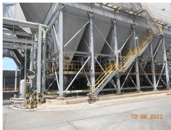
รูปที่ 17 อุปกรณ์ดักฝุ่นละออง (ESP)
