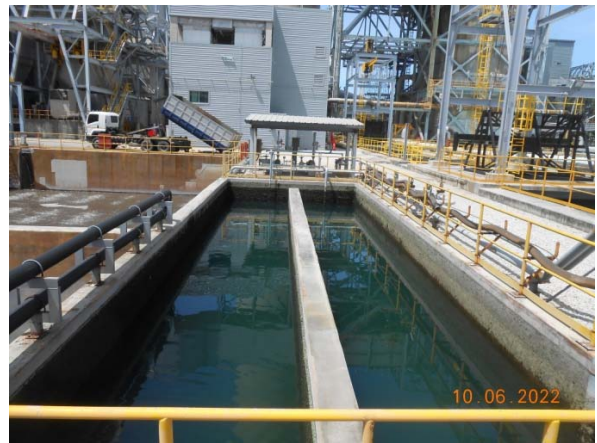
รูปที่ 33 บ่อพักน้ำทิ้ง (holding pond)
