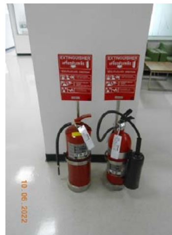
รูปที่ 100 เครื่องดับเพลิงแบบมือถือ
