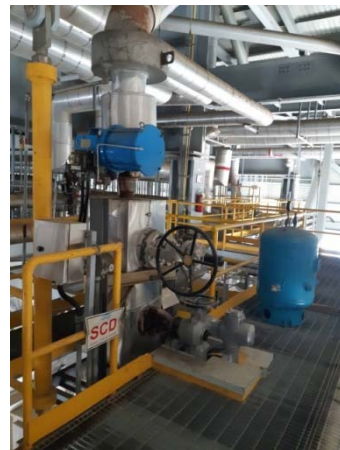
รูปที่ 102 อุปกรณ์ป้องกันอันตรายที่เกิดขึ้นกับหม้อไอน้ำ/ลีนินรภัย
