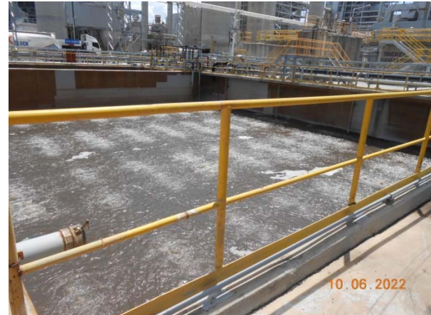
รูปที่ 37 บ่อพักน้ำทิ้งฉุกเฉิน (Abnormal Pond หรือ Retention basin)
