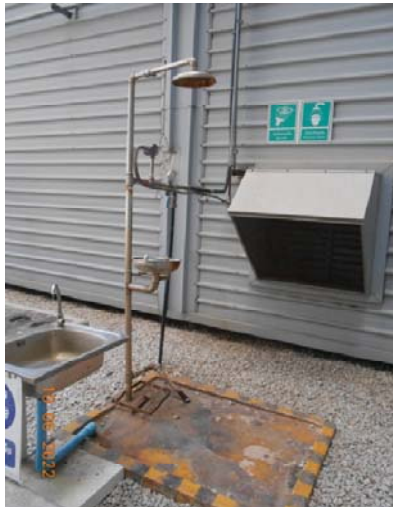
รูปที่ 97 อ่างล้างตาและร่างกายถูกเงิน
