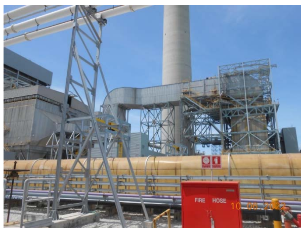
รูปที่ 18 อุปกรณ์ควบคุมก๊าซซัลเฟอร์ไดออกไซด์ (SW-FGD)
