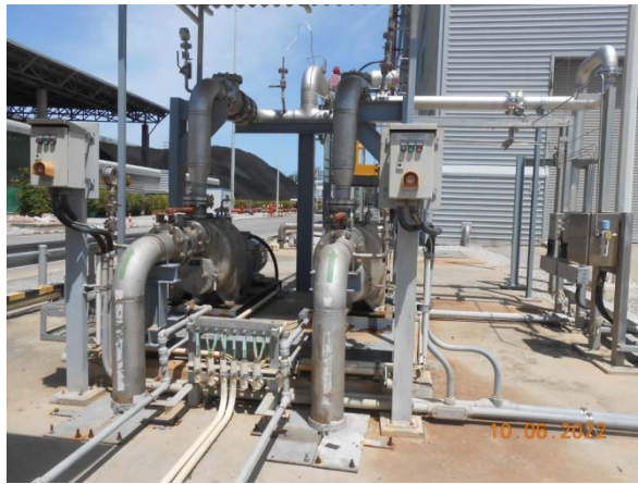
รูปที่ 34 ระบบปรับสภาพให้เป็นกลาง
