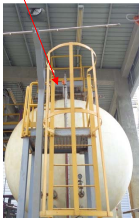
รูปที่ 103 อุปกรณ์ตรวจวัดแอมโมเนียบริเวณถังเก็บแก๊ส
