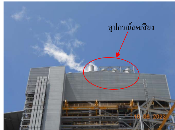
รูปที่ 28 อุปกรณ์ลดเสียง (Silencer) บริเวณจุดระบาย ไอน้ำของหม้อไอน้ำ
